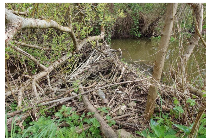
Dam No. 1 Burg Stargard, 24.04.25, 0,13 m³/s
